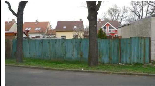
pohled jižní z ul. Tyršova
